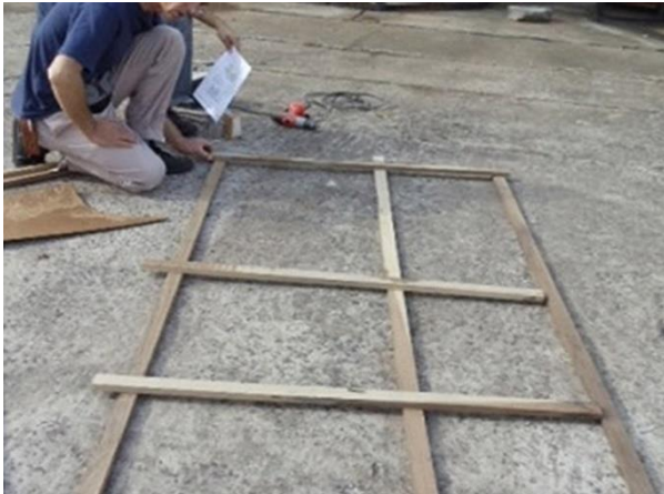
Este será uno de los laterales de nuestra caseta. Hay que armar 2 laterales
