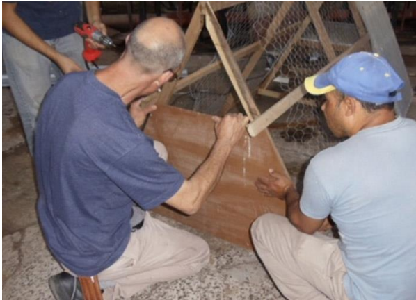
Cerramos la parte inferior de la caseta
