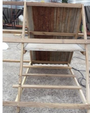
Instalamos el piso
