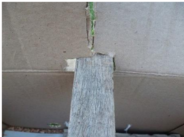
Colocamos el travesaño
