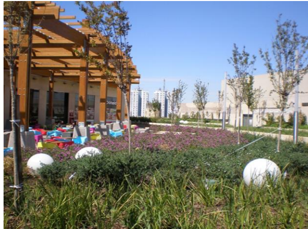
DOT Shopping / Shopping Comercial. Superficie: 6500 m 2 - Fecha de instalación: 2007
