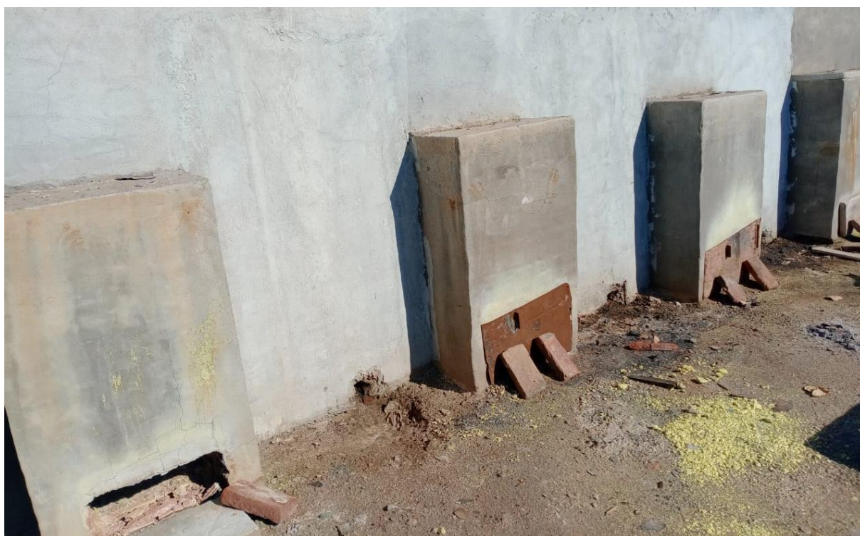
Imagen 11: Parte posterior de los azufraderos en donde se realiza el quemado del mineral.
